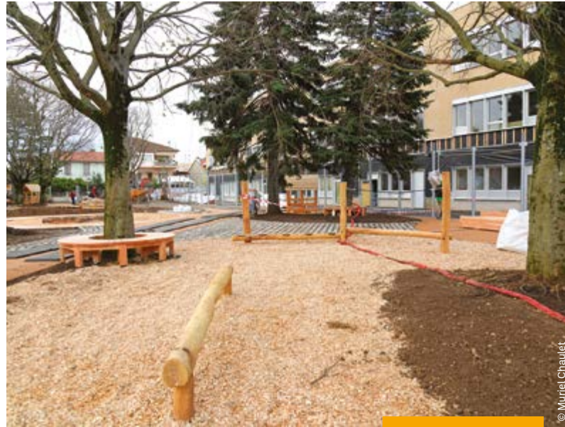
La future cour nature en travaux.
